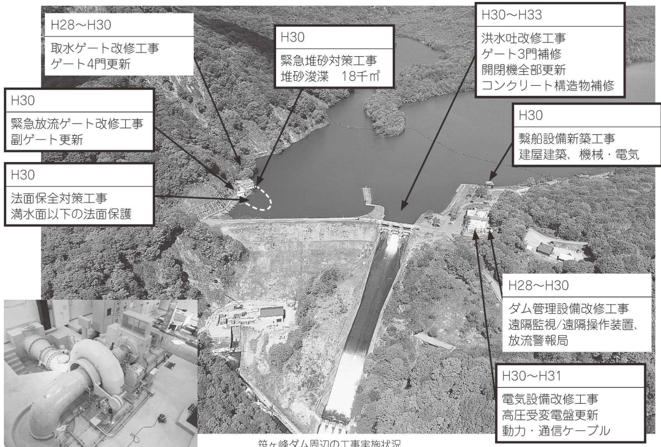
笹ヶ峰ダム周辺の工事実施状況
