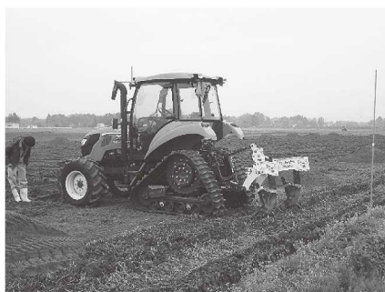
カットドレーンによる 補助暗渠の施工
