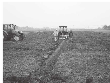
溝掘機による明渠の施工
