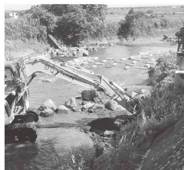
▲取水口整正工事 (大熊川頭首工)
